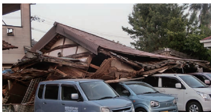
【写真1.1】前震で倒壊した比較的古い構法の木造家屋
