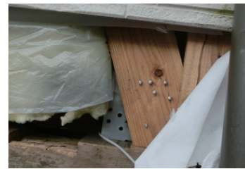
【写真2.4.9】写真2.4.8の箱型筋かい金物と古材(桁)
