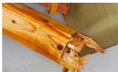
【写真2.1.3】写真2.1.1の住宅の柱脚の込み栓接合
