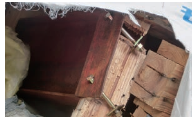
【写真2.4.10】 写真2.4.8の梁に使用された鉄骨
