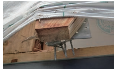
【写真2.4.6】 写真2.4.5の箱型筋かい金物
