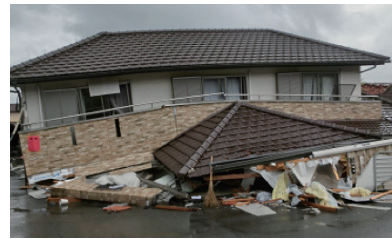
【写真2.4.8】 倒壊した比較的新しい戸建て住宅
