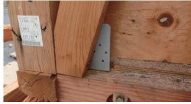
【写真4.5】写真4.4の箱型筋かい金物
