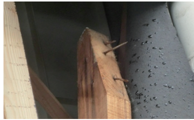
【写真2.4.2】 写真2.4.1の筋かい端部のくぎ打ち
