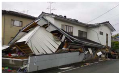
【写真2.1.1】新耐震以降の住宅の倒壊
