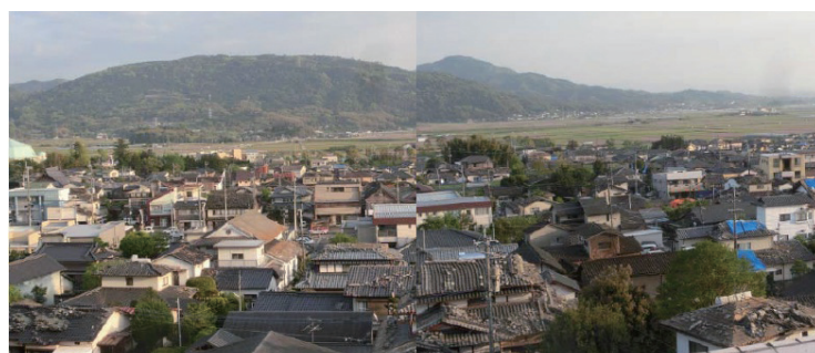
【写真1.2】町役場屋上から見た瓦屋根の被害（4月15日撮影）
