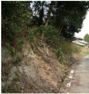
丘陵地は洪積層よりも古い第三紀の固い地盤で構成されている。
