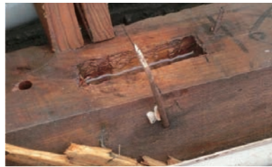
【写真2.4.3】 写真2.4.1の柱脚部のかすがい
