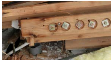
【写真4.6】写真4.4のホールダウン金物
