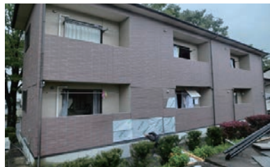
【写真2.4.5】 倒壊を免れた比較的新しい共同住宅
