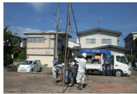
N値とは:外径51mmの先端サンプラーを持つロッドに63.5kgのハンマーを76cmの高さから落下させて、ロッドが30cm貫入する打撃回数。
