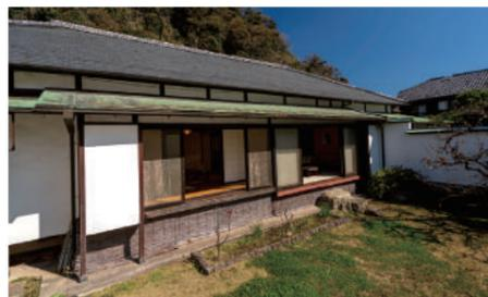
化粧土台が回り、柱や梁は朱で塗られています。既存屋根はスレート葺、壁は真壁が採用されています。
