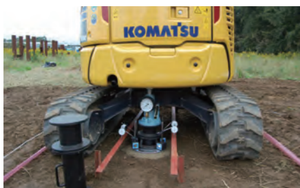
重機の直下が盛土地盤。その周囲は自然地盤。
