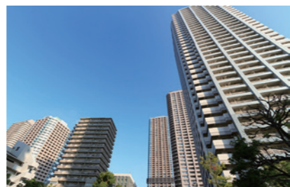
2000年代以降に急激に増え、現在も建築が続くタワーマンション。高強度コンクリートを使った物件も増えている。
