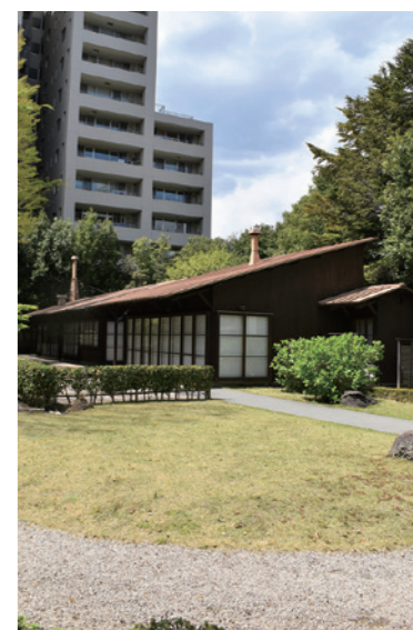
レーモンドが好んだ、勾配の緩やかな鉄板の片流れ切妻屋根。地震の時でも潰れないように、屋根を軽くするねらいもあります。
