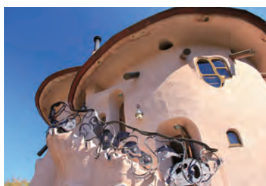
「トーベ・ヤンソンあけぼの子どもの森公園」内の建物。壁は珪藻土仕上げで、西洋の民家のような味わいを生み出している。
