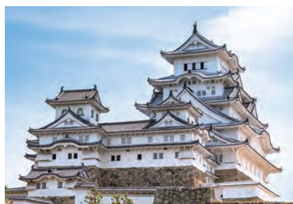
内壁や外壁、天井など表面全てを漆喰で塗られた姫路城。世界遺産に指定され、「白鷺城」とも呼ばれる。
