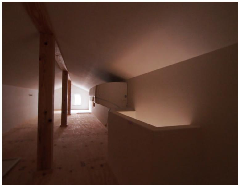
2階の小屋裏より、下の各居室に冷気を送る「冷房用エアコン」の設置例。
