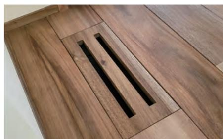
基礎断熱で起こる床下結露の予防として、床に換気のためのスリットを設けると良い。
