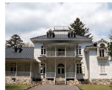
建物全体は、自然石の玉石を積んだ高さ約1.2メートルの基礎の上に建つ高床に。建築面積は96.6坪で、床面積(小屋裏部屋を除く)が146.9坪。
