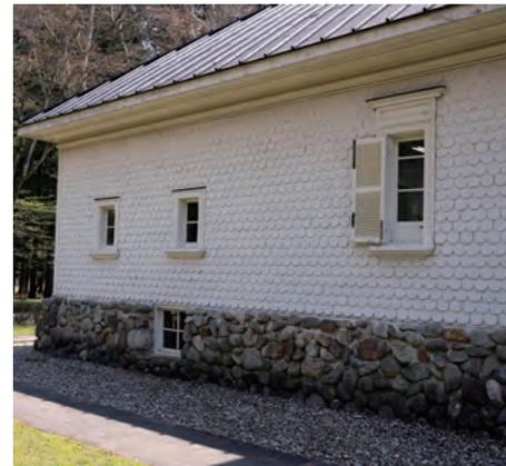
西棟の裏側の壁。西棟と東棟には小さな地下室が設けられていて、玉石の部分に地下室用の小窓が切られています。
