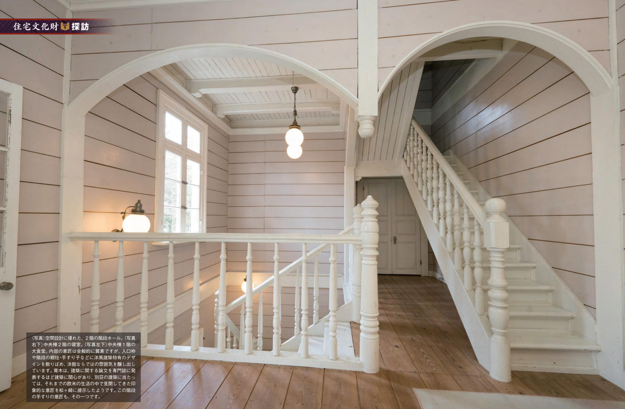
(写真)空間設計に優れた、2階の階段ホール。(写真右下)中央棟2階の寝室。(写真左下)中央棟1階の大食堂。内部の意匠は全般的に質素ですが、入口枠や階段の親柱・手すりなどに洋風建築特有のデザインを散りばめ、洋館ならではの雰囲気を出しています。青木は、建築に関する論文を専門誌に発表するほど建築に関心があり、別荘の建築に当たっては、それまでの欧米の生活の中で見聞してきた印象的な意匠を松ヶ崎に提示したようです。この階段の手すりの意匠も、その一つです。
