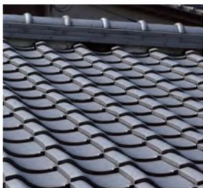
江戸時代に考案された棧瓦葺きの屋根。1種類の瓦で葺かれる。
