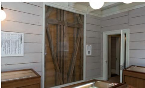
現在、1階居室の壁を一部ガラス張りにし、軸組を公開。柱の間隔が狭く、多くの筋交いを入れているのがわかります。
