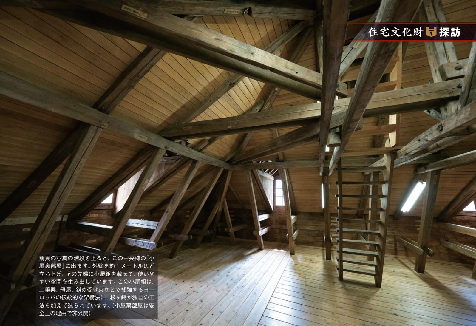
前頁の写真の階段を上ると、この中央棟の「小屋裏部屋」に出ます。外壁を約1メートルほど立ち上げ、その先端に小屋組を載せて、使いやすい空間を生み出しています。この小屋組は、二重梁、母屋、斜め受け束などで補強するヨーロッパの伝統的な架構法に、松ヶ崎が独自の工法を加えて造られています。(小屋裏部屋は安全上の理由で非公開)
