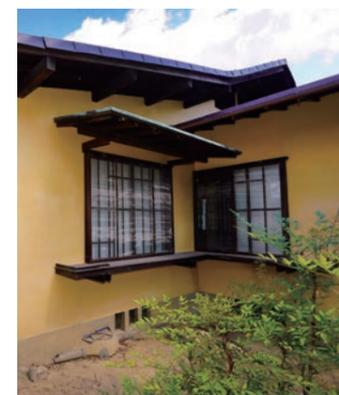
強い夏の日差しを防ぎ、雨の日も窓を開け放てるよう、軒と庇を深くしています。床下には換気口が設けられています。
