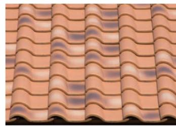
S形の瓦で葺いた屋根。丸みを帯びており、明るい色が多いので、柔らかい印象の屋根に仕上げられる。
