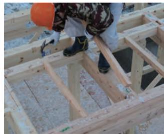
重たい厚物合板による剛床を、大工が高所で安全に施工できるように、足場用として45cmピッチで、落とし根太としています。
