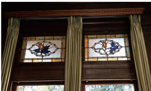
屋外から見た時に和風建築の意匠を損なわないよう、応接室のステンドグラスの外側にすりガラスを入れています。
