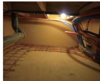
床下空間には、壁面に沿って11mmの温水パイプを4本巡らせています。床下は高さもあるのでメンテナンスが容易です。
