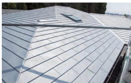
ガルバリウム鋼板で仕上げられた屋根。粘土瓦よりも施工しやすく、さまざまな工法で葺くことができる。
