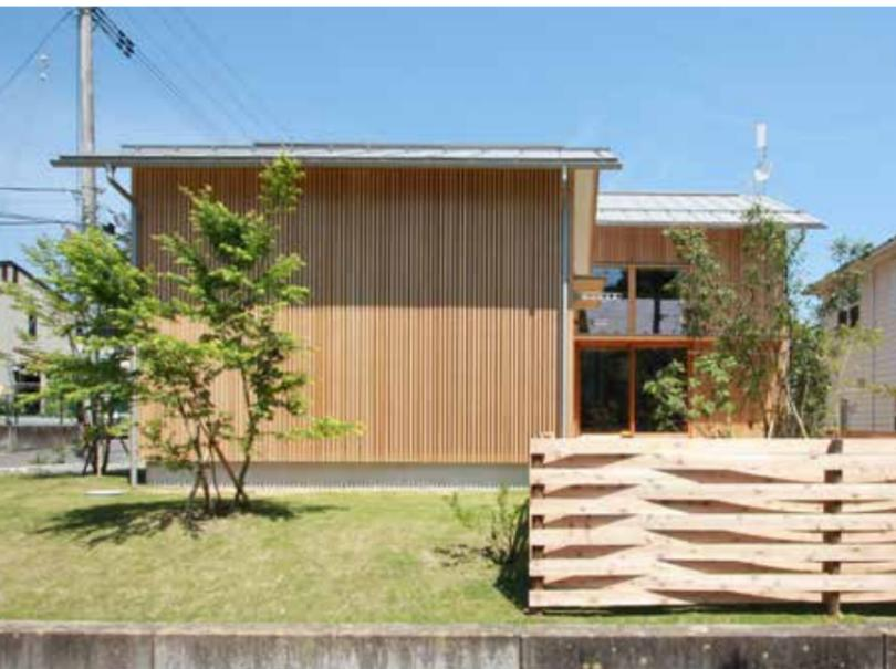
外壁のファサードラタンは、36mm角の野縁材を1本1本釘打ちで取り付けた。
