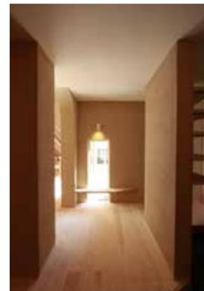
FIXの高窓にも障子を設け、夏の日射を調整。掃き出し窓が高さ1800mmと低めなので、上の障子も手で楽に開け閉めが可能
