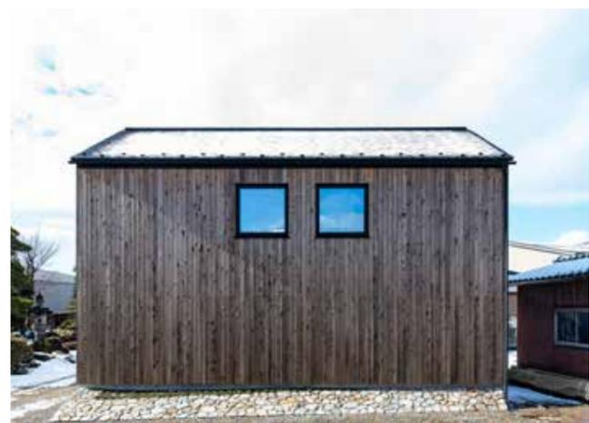
側面の外壁は県産材を生かしたスギ板張り。必要十分に絞り込まれた開口部はシンメトリーに配置。佐藤さんが初めて断熱性能G3に本腰を入れて挑戦した物件。
