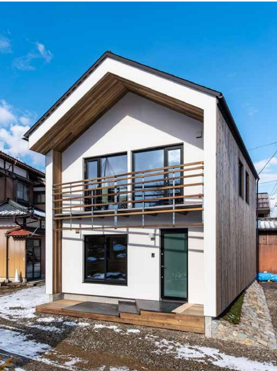
延床面積24坪の総2階。付加断熱の壁や屋根の厚みがそのまま現れた外観。バルコニーを斜めにすることで、敷地内の庭を眺めるための方向性を示唆。玄関ポーチの雪除けに出した深い軒も外観を特徴づけている。
