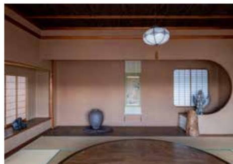
朝陽の間。曲面を多用した意匠と、床柱の代わりに用いられた変木、瑠璃壁、神代杉の天井板など、贅沢な建材でしつらえた15畳の大空間で、客人を迎えた。中庭に面する東側と南側に畳敷きの縁側が回る。写真下に見える櫺の円卓も朝倉が設計した。
