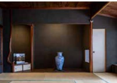
2階素心の間。空間を引き締める黒土壁。陳列した作品に光が回るよう、床の間壁の隅部はアールになっている。
