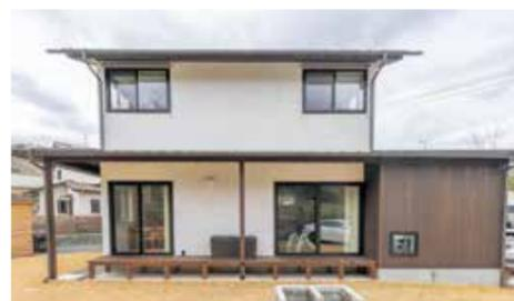
部屋の角に開口部を設けたことが外観の特徴にもなっている。軒と庇で、窓の汚れやそとん壁塗りの外壁の劣化を防ぐ。右側の板張り部分が小さな正方形の玄関。
