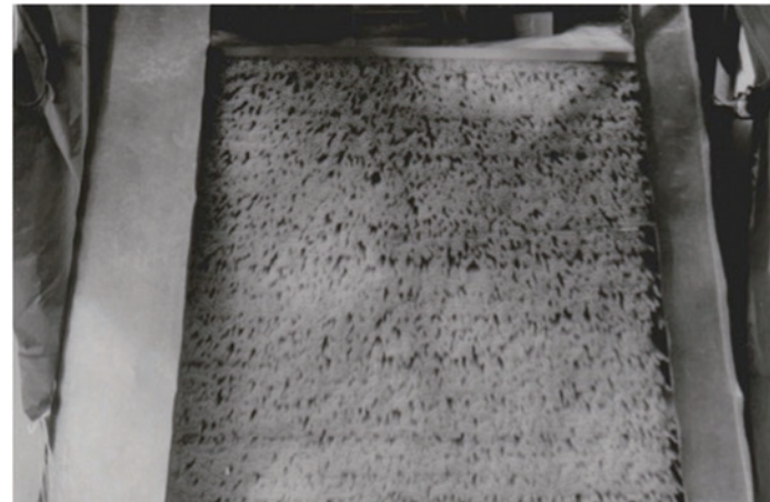
径8mm、長さ50cmのポリプロピレンストロー5000本を、1段ごとにスペーサーを挟んで葺き重ねた。スペーサーの部分には漏水センサーが入っている。
